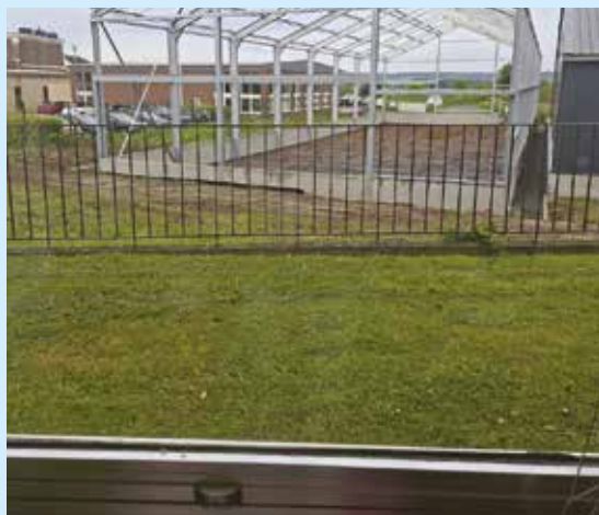
Der Padelplatz in der Bauphase, mit Blick aus dem Schulfenster!
